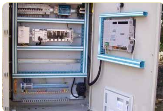
Armoire Predifloc™ avec automate
